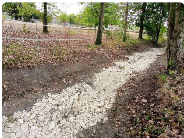
Recharge granulométrique moitié aval pont
