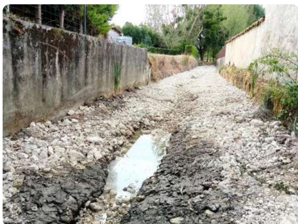
Recharge granulométrique aval pont avec banquettes 1m au pied des murs
