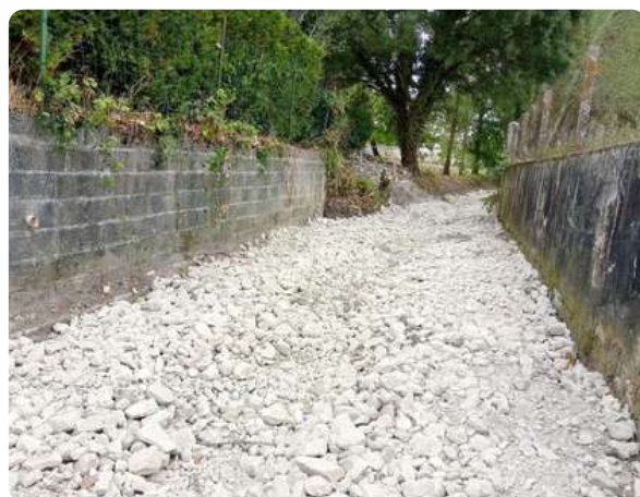
Recharge granulométrique moitié aval pont
