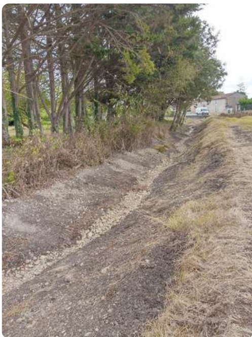
Recharge granulométrique tronçon amont
