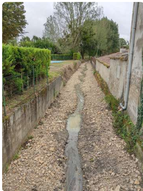
Recharge granulométrique tronçon amont
