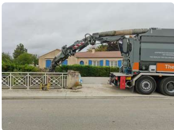
Aspiration des matériaux sous l'ouvrage
