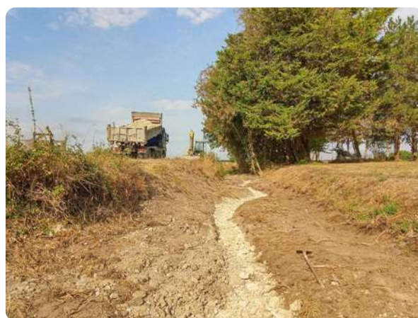
Recharge granulométrique moitié amont pont avec banquettes terre
